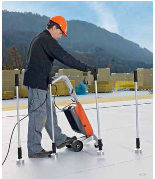
Oft bilden Setzgerät und Befestiger ein Gesamtsystem bei Befestigungslösungen im industriellen Leichtbau.
